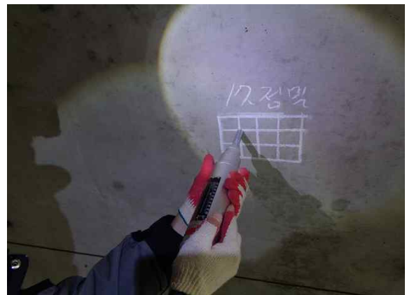
반발경도 측정 현황(측벽부)
