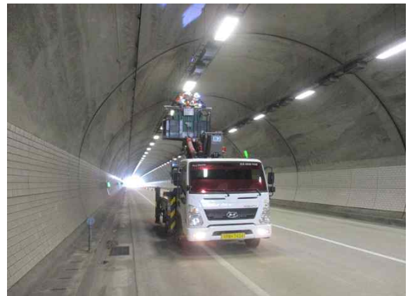
고소작업차를 이용한 외관조사 현황②
