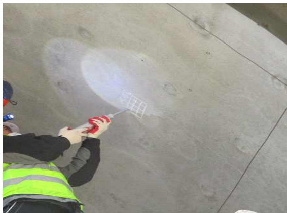
반발경도 측정 현황(측벽부)
