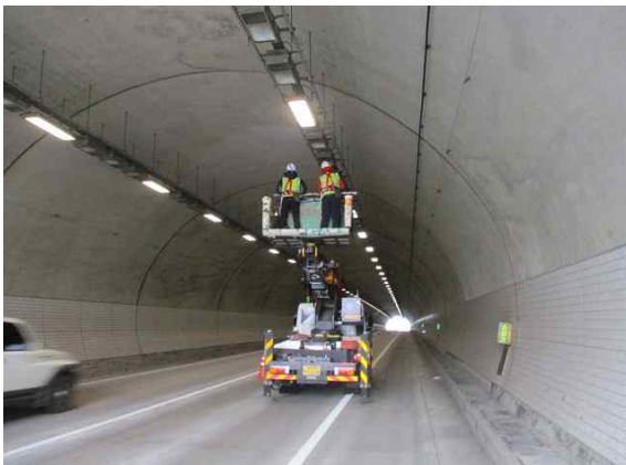
고소작업차를 이용한 외관조사 현황①
