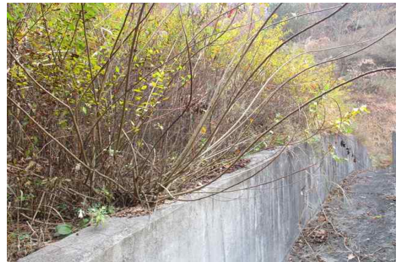
종점부 사면 전경
