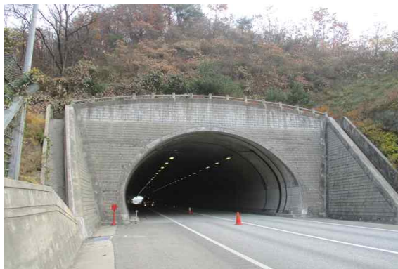
시점부 갯문 전경
