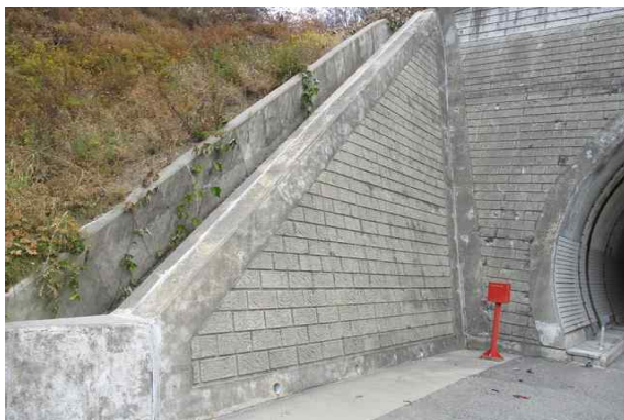
시점부 옹벽 전경
