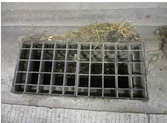
배수시설 집수구 전경
