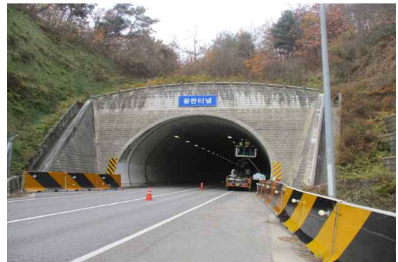
중점부 갯문 전경
