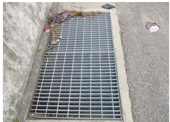
배수시설 집수구 상태양호
